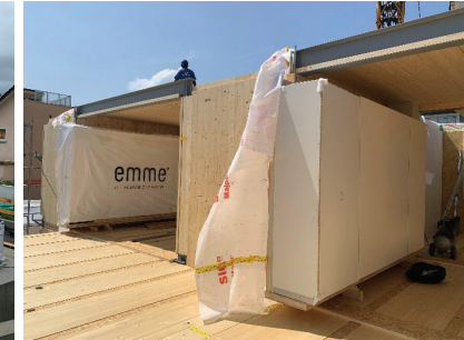
Abbildung 14: Küchen- und Badmodule mit Stahlträger
