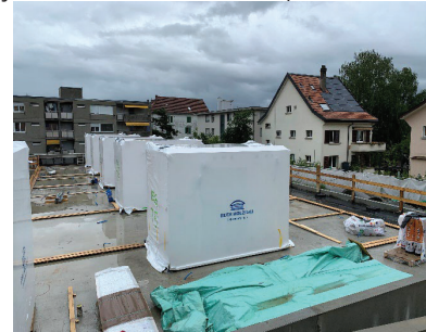
Abbildung 13: Badmodule EG
